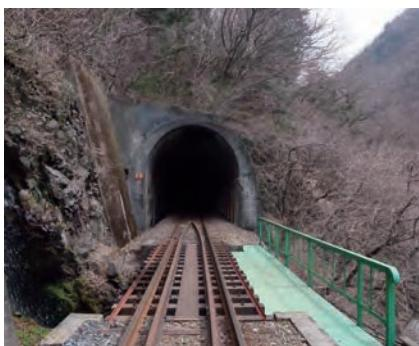
神戸駅から上り線で約1分で見えはじめます。第二神土トンネルから第一神土トンネルは約1分で通過します。建設当時は、内部全体が煉瓦積みでしたが、昭和33年に小中駅側の入口に落石覆いを増築したため全長123mとなりました。渡良瀬川の対岸の小中駅側入口と神土沢橋梁が見られる場所は、紅葉の季節には撮影ポイントとなります。
