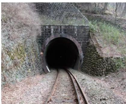
小中駅から下り線で約2分で見えはじめます。第一神土トンネルから第二神土トンネルの通過時間は約1分です。造られた当時のトンネルは、側壁を切石積み、天井を煉瓦積みとしていましたが、事故防止のため神戸駅側入口に落石覆いを昭和33年に増築したため、全長103mとなりました。
