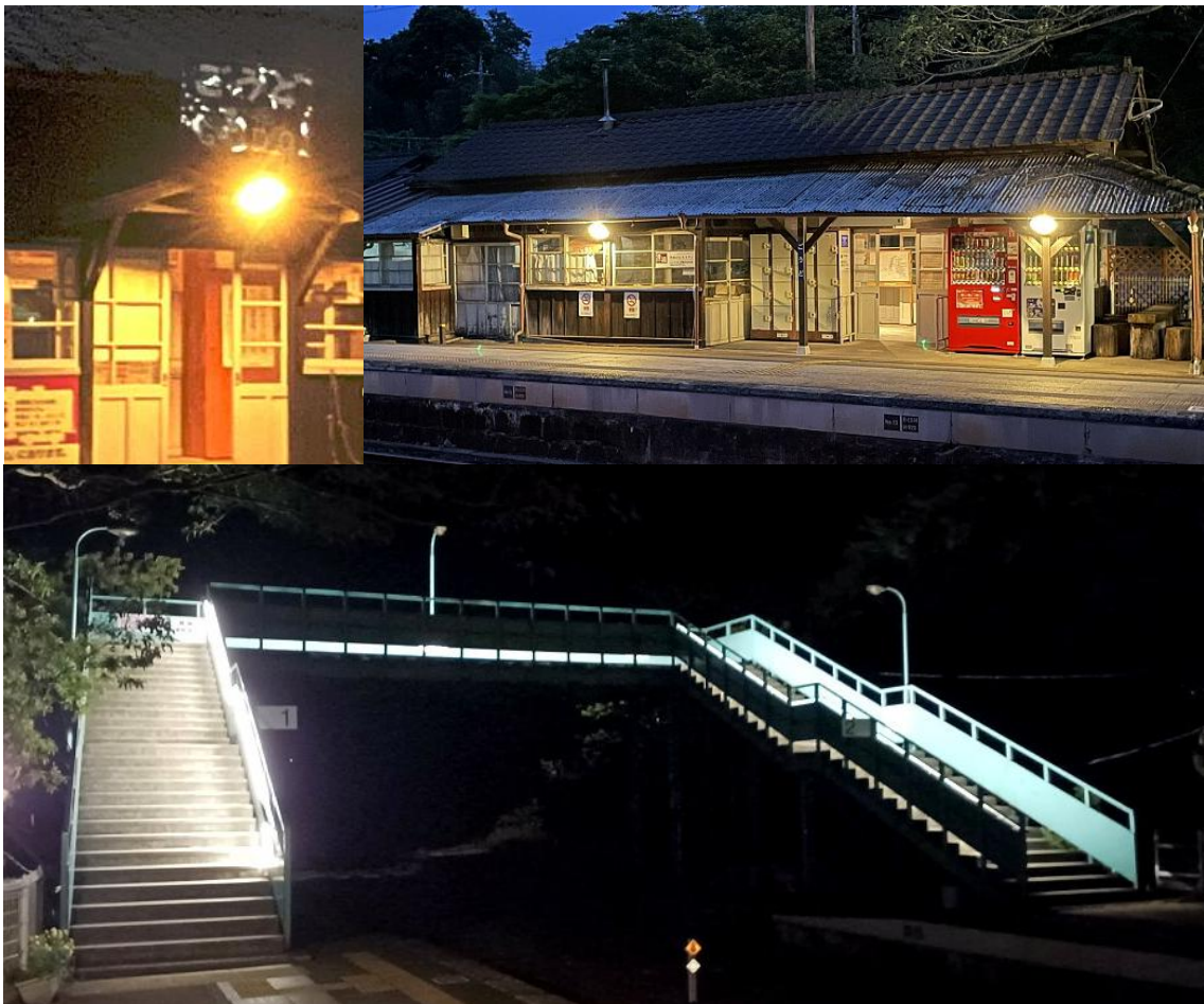
(神戸駅構内照明のLED化)
