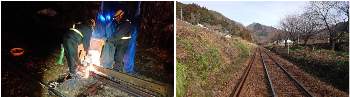
<神戸～沢入間レールの重軌条化工事>
